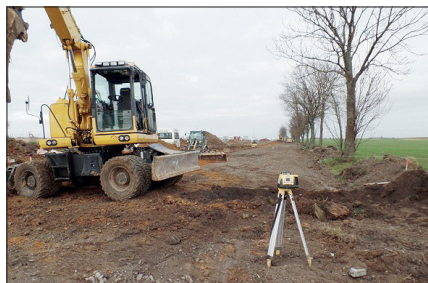
Przebudowa drogi powiatowej w Kornicach
